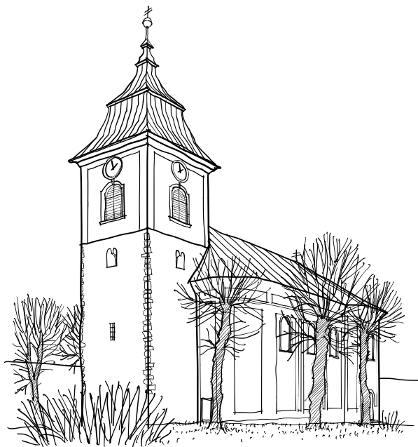
Kostel sv. Bartoloměje - Luka nad Jihlavou / - TC -
