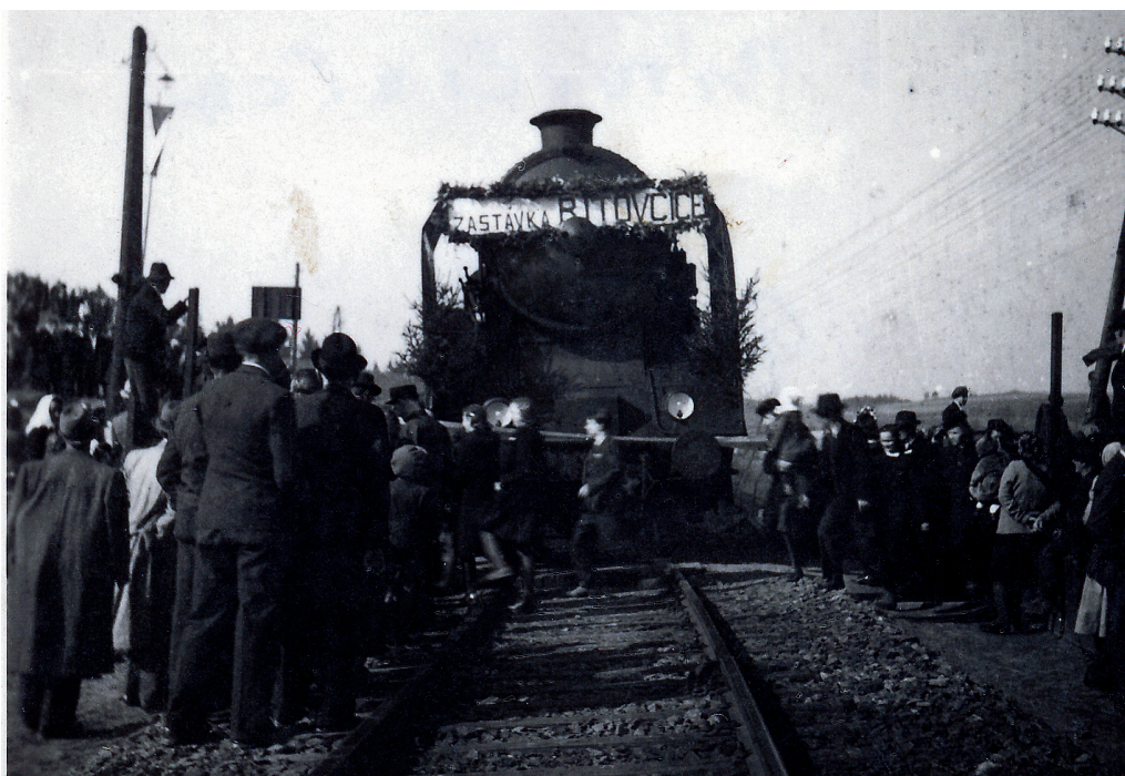
Bítovčice -zřízení železniční zastávky 16. března 1947 / foto -archiv-
